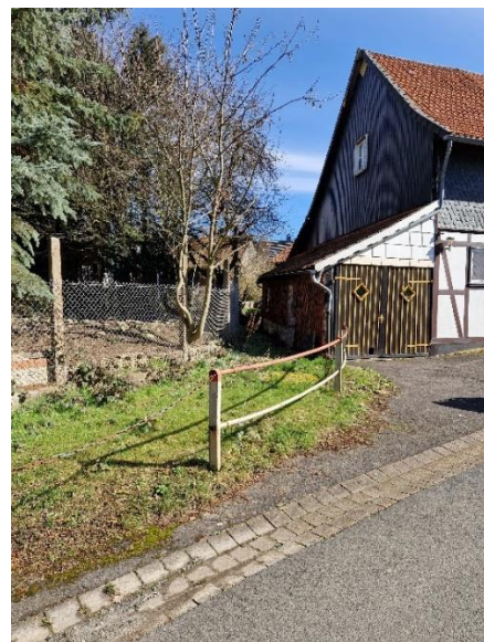
verrohrter Bach hinter Bachstr. 3; eigenes Bild
