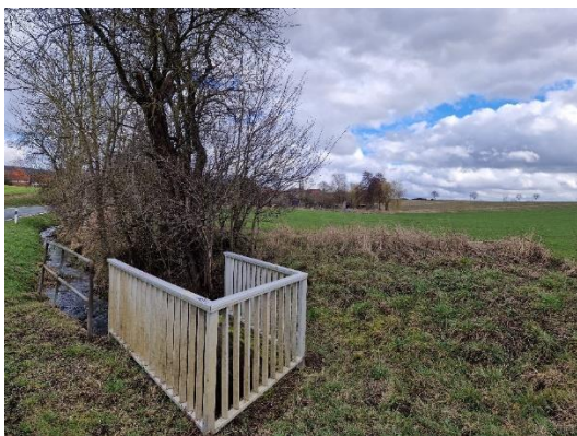
Mögl. Speicherbereich südlich Brücke K634; eigenes Bild
