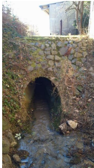
Verrohrung Ackenhausen Am Brunnen; eigenes Bild
